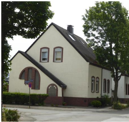
Zweifamilienhaus, renoviert verputzt
